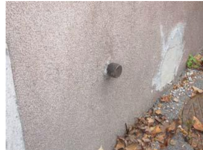
Niski reper u obliku kugle(valjka) Ugrađen u zid objekta (0,50-0,70 m)
